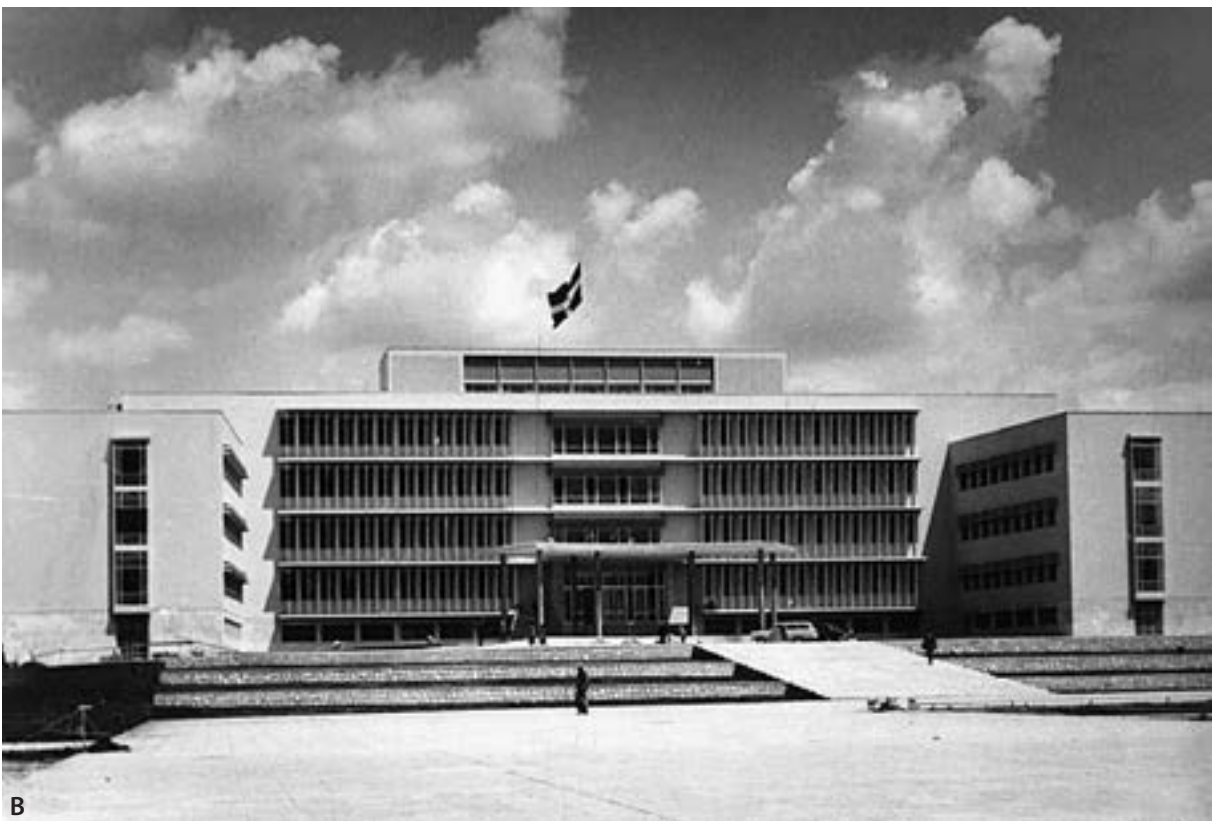
Εικόνα 2.7 Α. Το υπό ανέγερση κτίριο της Φυσικομαθηματικής Σχολής το 1959 και Β. η ολοκληρωμένη εικόνα αυτού. (ΑΠΘ-Συλλογή Β. Κυριαζόπουλου).
