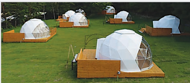
Εικόνα A.29 Viking dome glamping (glamorous camping). Ο θόλος αποτελείται από τρίγωνα σε διάταξη κολοβού 20εδρου που διαθέτει 12 5εδρα και 20 βεδρα ή πολλαπλάσια του 20. Μέση διάμετρος 6 μ., μέσο ύψος 3,75 μ.
