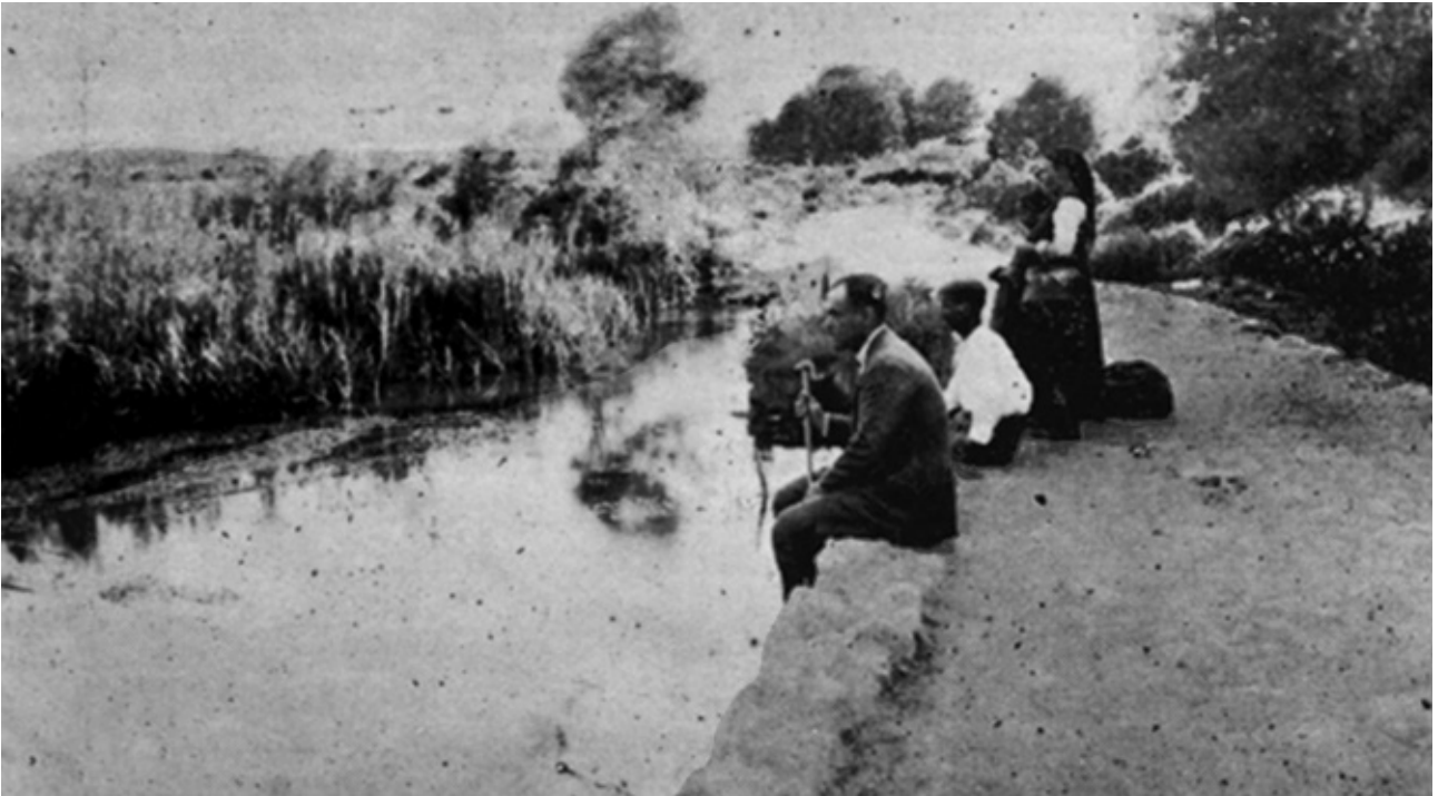
Εικ. 2. Η πέτρινη γέφυρα του ποταμού Βαφύρα και στο βάθος το αρχαίο Δίον (πηγή: Γ. Σωτηριάδης, Περί το Δίον της Μακεδονίας, Ημερολόγιον Θεσσαλονίκης 1930, 6).
