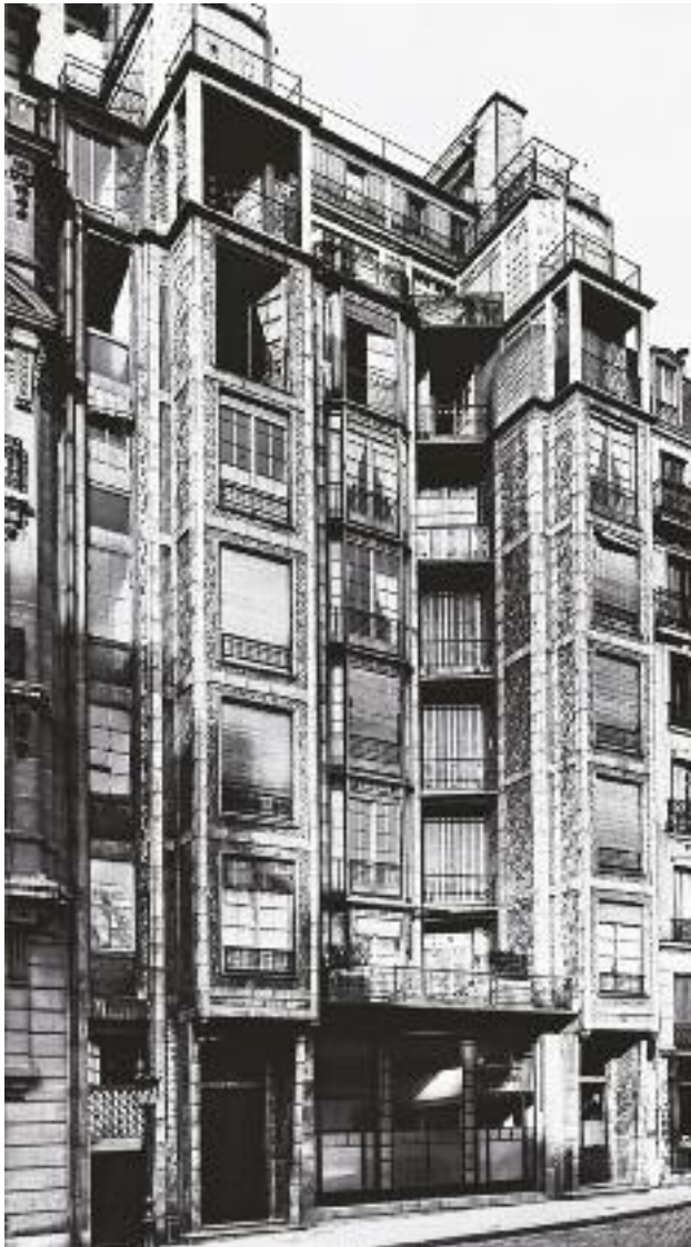
42 Κτήριο κατοικιών, οδό Franklin 25, Auguste Perret, Παρίσι, Γαλλία, 1903-1904.
