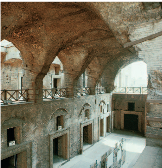
Εικ. 6.8. Ρώμη, Εμπορική αγορά του Τραϊανού, aula . 100-112 μ.Χ. Πλινθοδομή και χυτή τοιχοποιία
