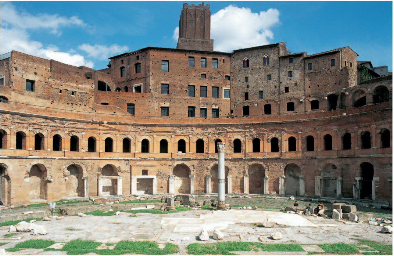
Εικ. 6.6. Ρώμη, Εμπορική Αγορά του Τραϊανού. 100-112 μ.Χ. Πλινθοδομή και χυτή τοιχοποιία
