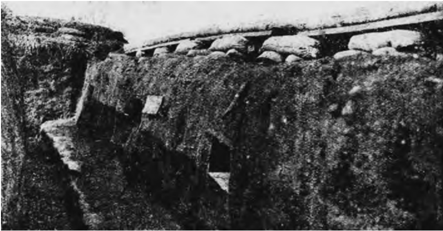
Στρατιωτικά χαρακώματα που «κόβουν» την Τούμπα της Μπάλτζας (Μελισσοχώρι), κατά τη διάνοιξη των οποίων συχνά εντοπίζονταν αρχαιότητες. (Πηγή: L. Rey, 1916, Observations sur les sites préhistoriques et protohistoriques de la Macédoine, Bulletin de Correspondance Hellénique 40, σελ. 264, εικ. 5b.)
