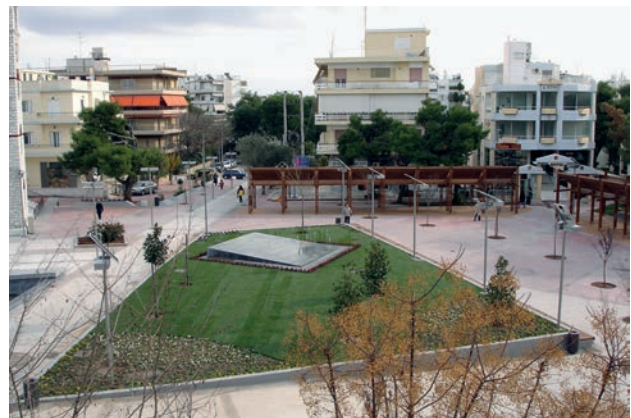
Εικόνα 2.5. Πανοραμική άποψη των αυτόνομων φωτιστικών σωμάτων και των περγκολών με τα φωτοβολταϊκά πάνελα.
