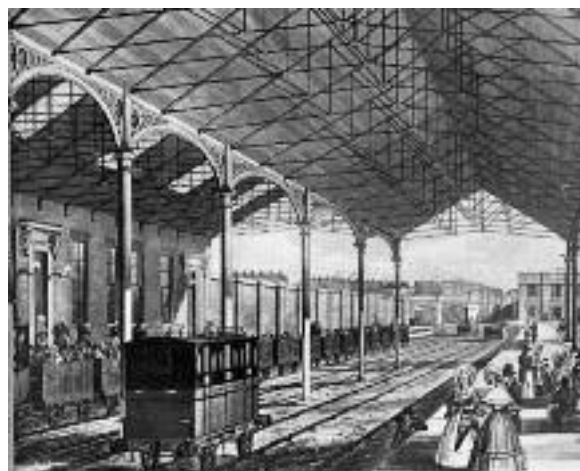
6 Άποψη των αποβαθρών μετεπιβίβασης του σιδηροδρομικού σταθμού Euston, στο Λίβερπουλ. Διακρίνονται οι χυτοσιδηροί στύλοι και οι τμηματικές αψιδωτές δοκοί καθώς και τα σιδηρά στέγαστρα των αποβαθρών. (σχέδιο του T.T. Berry 1837)
