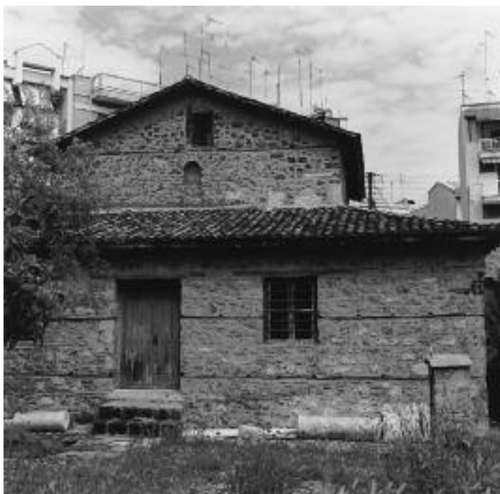
Εικ. 4. Δυτική όψη του ναού των Αγίων Κηρύκου και Ιουλίτιης, στη Βέροια (φωτ. Ν.Κ.Μ., 1970).
