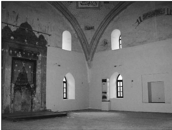
Εικ. 15. Το εσωτερικό του τεμένους μετά τις εργασίες. Fig. 15. The interior of the mosque after the restoration.
