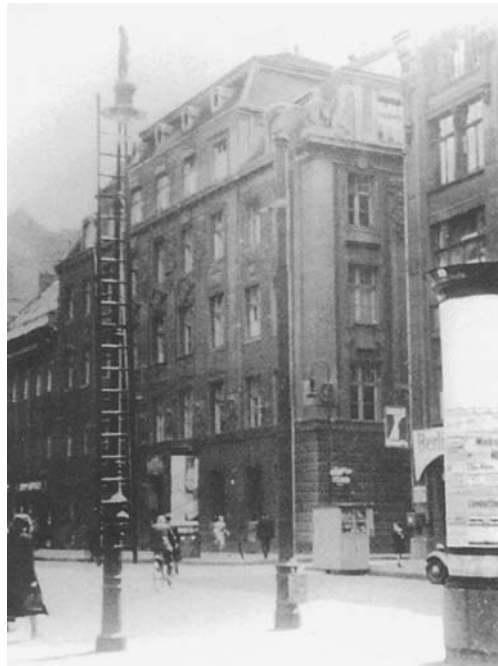
Ροζενστράσσε 2-4, το κυβερνητικό κτίριο της Εβραϊκής Κοινότητας όπου οι Εβραίοι που είχαν κάνει μικτούς γάμους είχαν τεθεί σε περιορισμό κάτω από την επιβλεψη των SS κατά τη διάρκεια του Τελικού Μαζέματος των Εβραίων που άρχισε στις 27 Φεβρουαρίου του 1943 και που υπήρξε ο τόπος διαμαρτυρίας των Εβραίων μελών της οικογένειάς τους.
