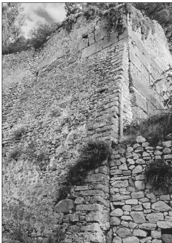
Εικ. 9. Εξωτερικός περίβολος, ορθογώνιος πύργος στην νοτιοανατολική γωνία, πόρινοι δόμοι κτισμένοι κατά το ισόδομο σύστημα με εγχάρακτα ελληνικά γράμματα (φωτογραφία Ν. Ιωαννίδου).
