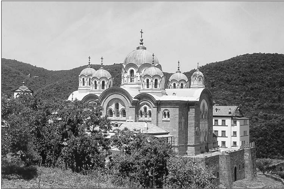
Εικ. 8. Σκήτη του Προφήτη Ηλία. Ο Κυριακός ναός. Θεμελιώθηκε το 1900 σε σχέδια του αρχιτέκτονα Προκοφίεβιτς.
