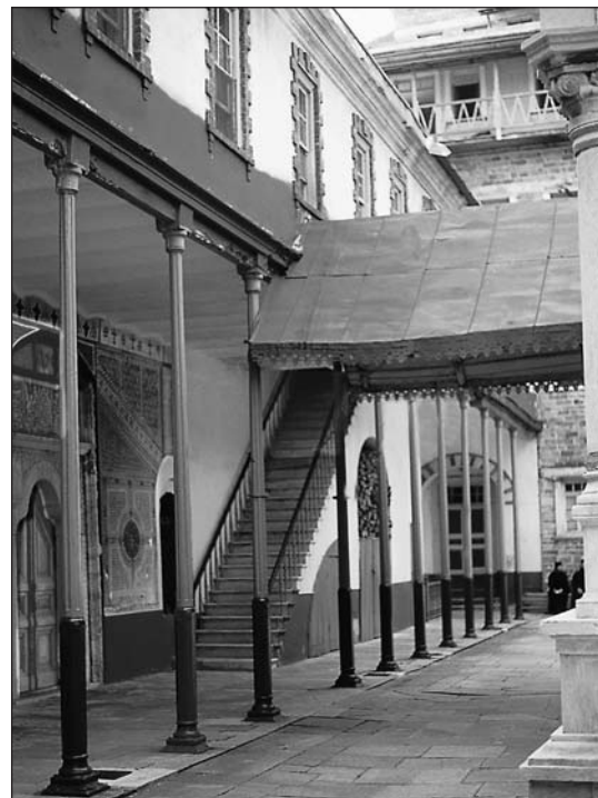
Εικ. 18. Ιερά Μονή Αγίου Παύλου. Εσωτερική όψη της δυτικής πτέρυγας. Μεταλλική κιονοστοιχία Διαβατικού.
