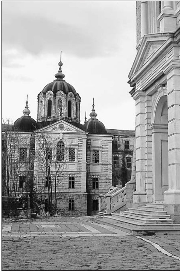
Εικ. 6. Σκίτη του Αγ. Ανδρέα. Όψη της βόρειας πτέρυγας. Διακρίνεται ο Ιερός Ναός του Αγ. Ιννοκεντίου (1910).
