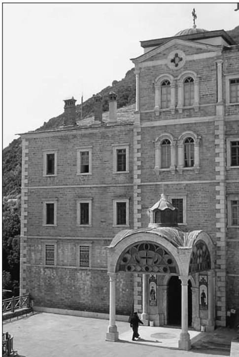
Εικ. 17. Ιερά Μονή Αγίου Παύλου. Όψη της νότιας πτέρυγας (1902) με το πρόπυλο.
