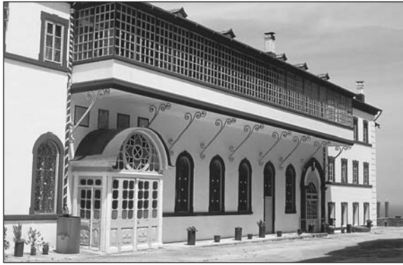
Εικ. 10. Σκίτη του Προφήτη Ηλία. Όψη της βόρειας πτέρυγας.
