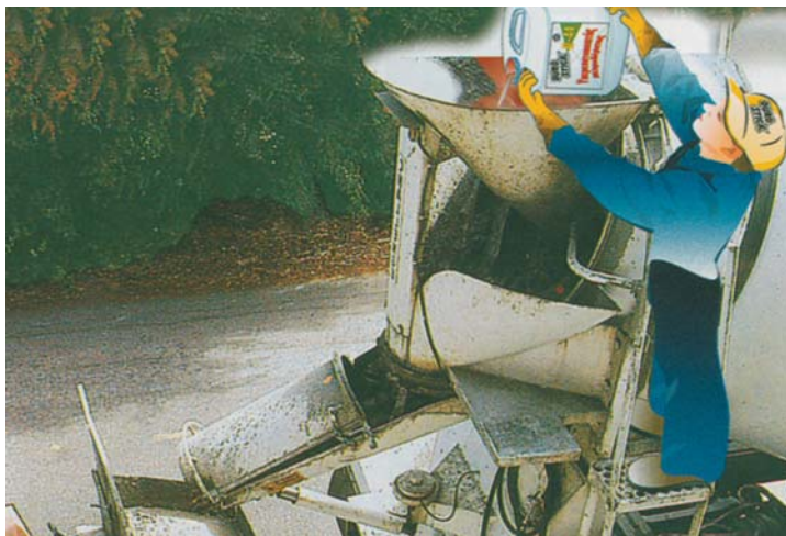
Πρόσμιξη ρευστού στεγανωτικού υλικού με σκυρόδεμα.
