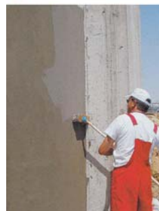
Διάστρωση δώματος και τοιχοποιίας υπογείου με ρευστό υλικό επικάλυψης.
