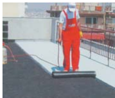
Επίστρωση συνθετικής μεμβράνης κατά τη στεγανοποίηση δώματος.
