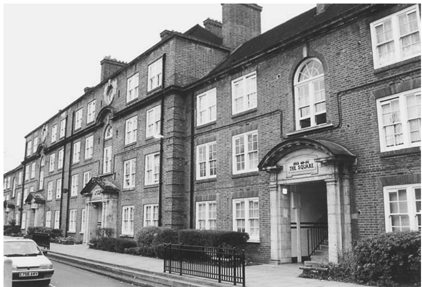
Εικ. 23, 24. Το συγκρότημα Πίμποντι Σκουαίρ, στην οδό Queen Caroline, στο Hammersmith του Λονδίνου, χτισμένο πιθανώς στις αρχές του 20 ου αιώνα. Τα διαμερίσματα διατάσσονται εκατέρωθεν του κεντρικού κλιμακοστασίου, πράγμα που δίνει μικρές διαστάσεις στις κτιριακές μονάδες και ευελιξία στη σύνθεσή τους. Προ το 1870 η επικρατούσα διάταξη κατά μήκος ενός διαδρόμου προσπέλασης παρήγαγε κτίρια με πολύ μεγάλο πλάτος και μονότονες όψεις.
