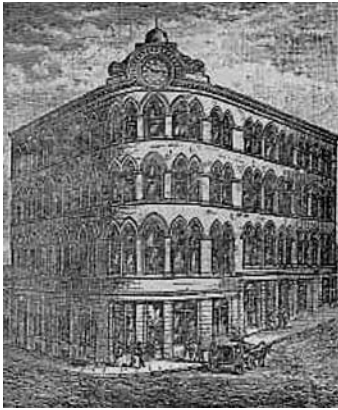
Εικ. 6. Το κεντρικό κατάστημα του Συνεταιρισμού των Δικαίων Πρωτοπόρων της Ροττοντέηλ, που άνοιξε το 1867 στην οδό Toad Lane (το πρώτο, του 1844, είναι σήμερα μουσείο του κινήματος).
