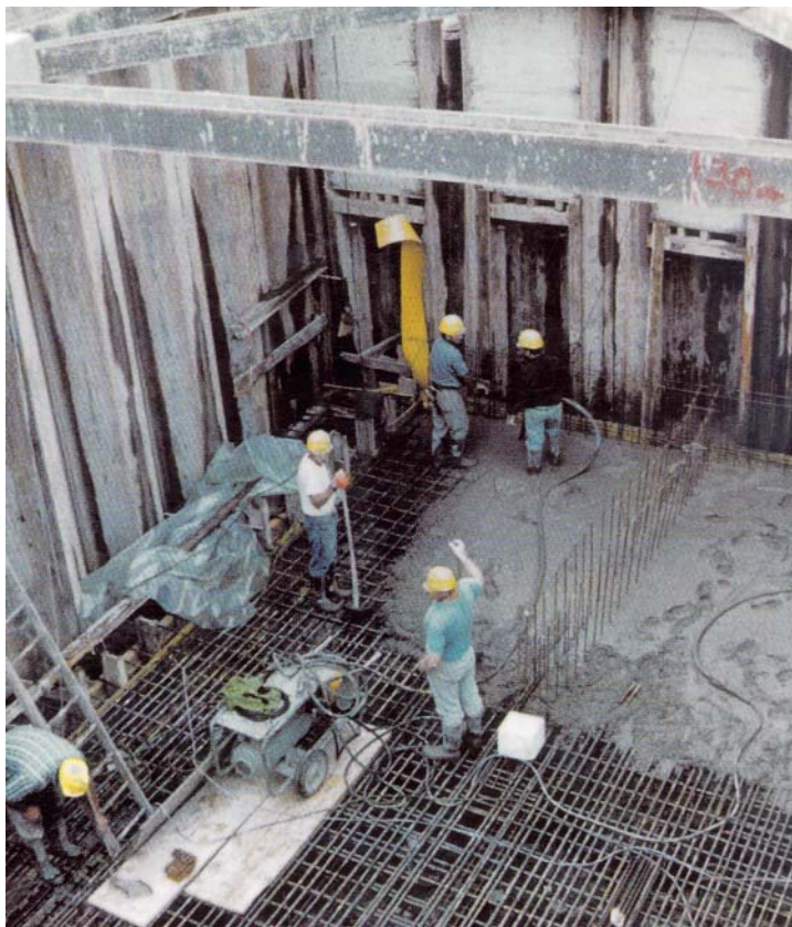
Σκυροδέτηση πλάκας υπογείου με αντιστήριξη στην πλευρά του δρόμου
