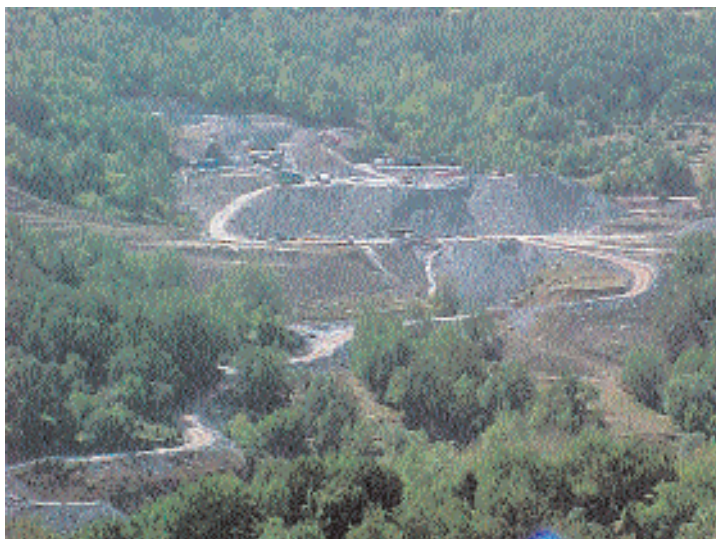
Εικόνα 2. Αποθεσιοθάλαμοι με προϊόντα εκσκαφών οδικής σήραγγας.
