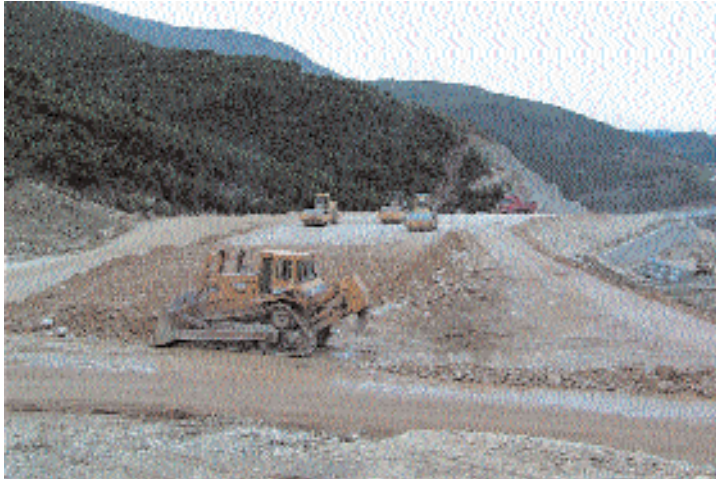
Εικόνα 3. Οδικό επίχωμα σε φάση κατασκευής.
