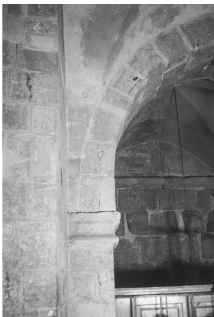
Εικ. 25. Βόρειος πεσσοί: Τόξο και γένεση σταυροθολίου.
