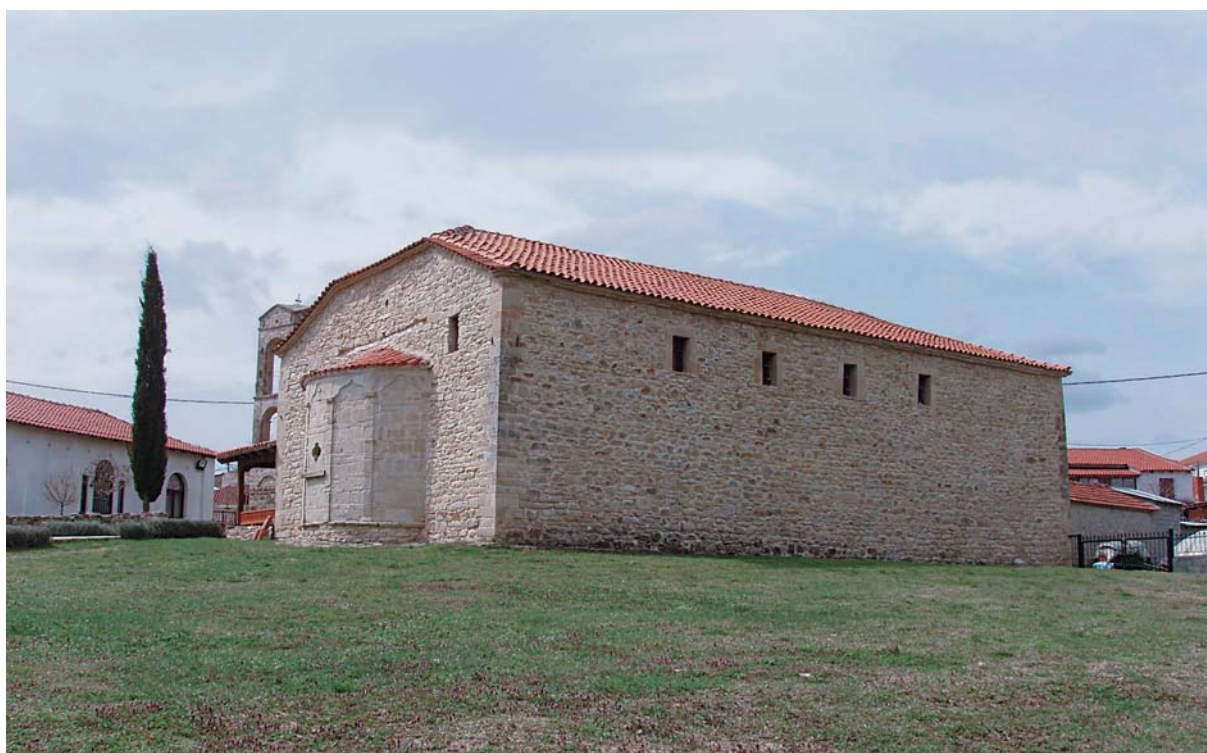
Εικ. 65. Κνίδη. Κοίμησις της Θεοτόκου (1873). πάνω: Α. άποψη (φωτ. 1996), κάτω: ΒΑ άποψη μετά την αναστήλωση και τη συντήρηση (φωτ. 2005).
