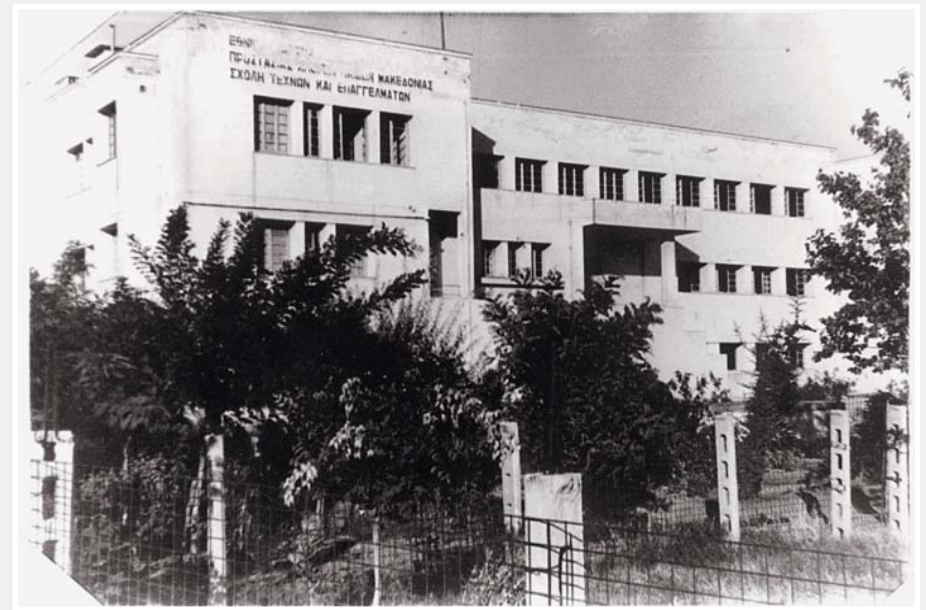
3. Πρόσψη κεντρικού κτιρίου του Ιδρύματος (1947).
