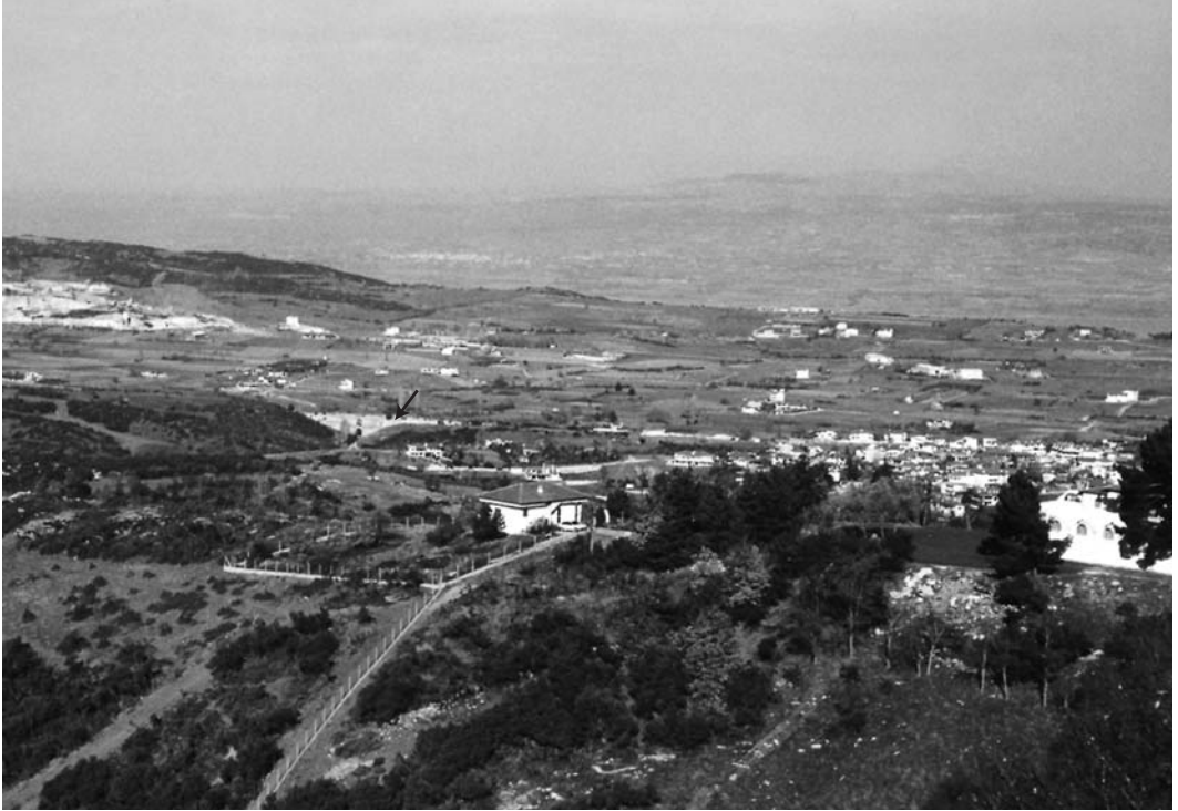
Εικόνα 6. Χορτιάτης, Υδατογέφυρα (στο κέντρο της φωτογραφίας).
