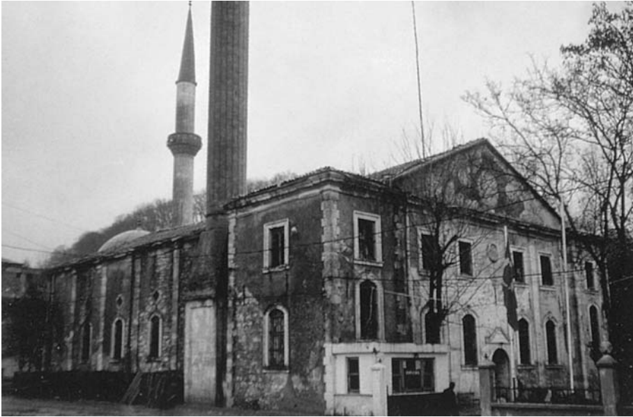
Εικόνα 3. Το κτίριο του ναού της Αγίας Παρασκευής δίπλα στον ποταμό Βορβύση (Αλίμπη). Σήμερα είναι αποθήκη του Δήμου Μπογάζκιοϊ με πρόσφατες κατασκευές μπετόν στο εσωτερικό και παρακείμενο τέμενος. Από την έκδοση του Πολιτιστικού Αναπτυξιακού Κέντρου Ξάνθης (ΠΑΚΕΘΡΑ), Χάρτης αριθμ. 7, Ανατολική Θράκη, Ιχνηλασία, Ξάνθη 2001. Άδεια αναδημοσίευσης από το ΠΑΚΕΘΡΑ
