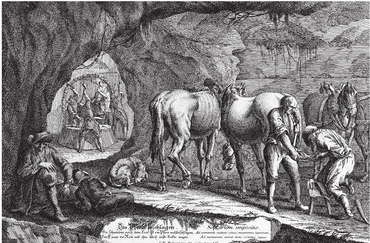
Εικόνα 14. Πεταλωτήριο και στο βάθος πεταλουργείο.
